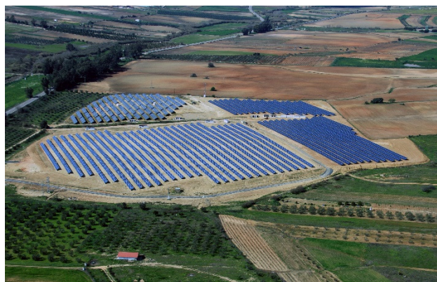
2.3 MW-Anlage Renovables del Condado in Almonte
