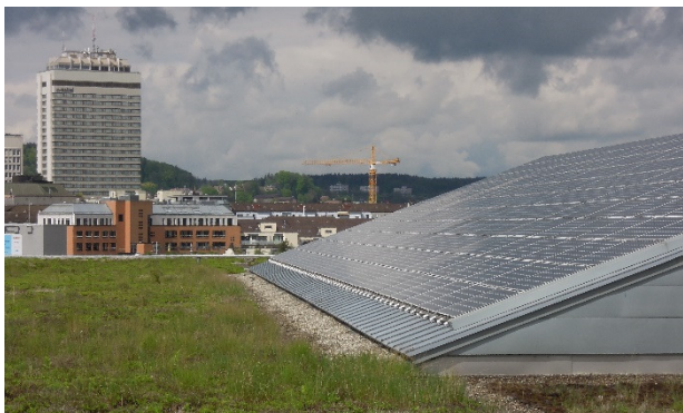
145 kW-Anlage Messe Zürich in Zürich-Oerlikon
