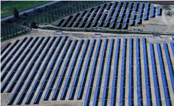
2.3 MW-Anlage Renovables del Condado in Almonte
